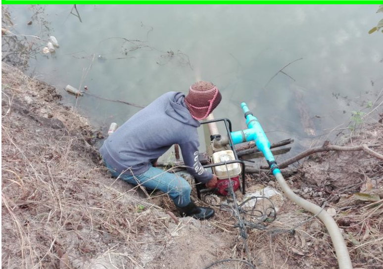
灌水ポンプ設置の様子
