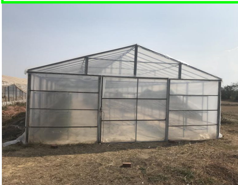
張り替えたビニールハウスの様子
