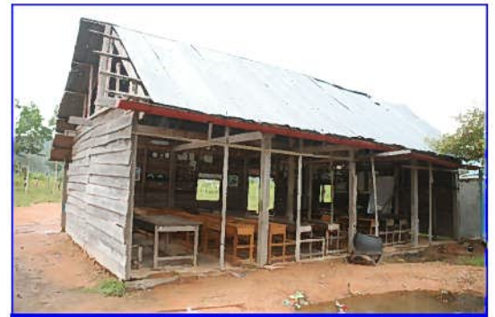
トモローン小学校 壁がなくトタン屋根でできた校舎
