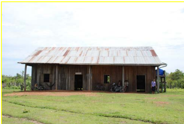
クラチエ州セイレッカ小学校 トタン屋根と木の壁の校舎
