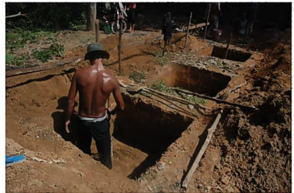
学校建設作業中
