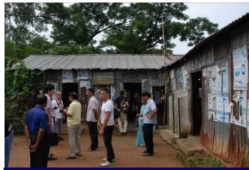
スラムにある小学校校舎
