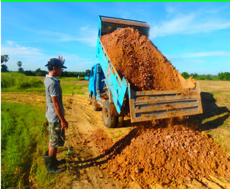
トラックで土を運搬している様子
