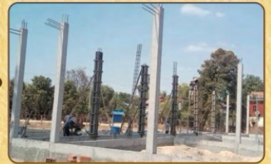
3 壁の中心となる柱を立てる
