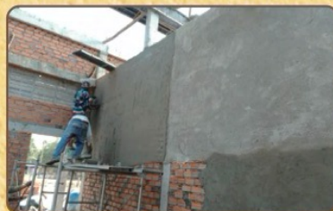
5 壁と床をモルタルで塗り固める
