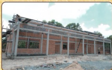
4 ブロックを積み上げて壁を作る
