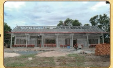
6 鉄筋の梁を渡し、骨組みを組み立て屋根を作る
