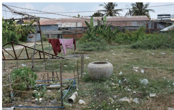
①校舎が倒壊してしまった
